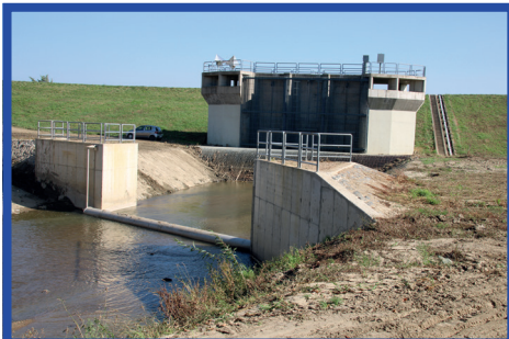
Új uszadékterelő műtárgy
