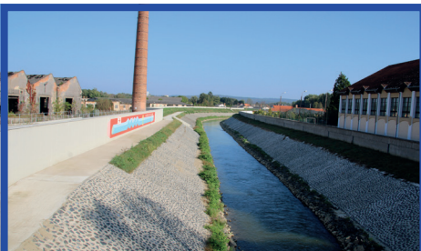
Szentgotthárd, Rába jobb part mederrendezése
