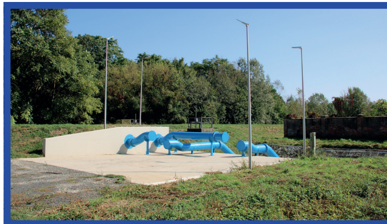
Felépítményi munkák Sárváron, az Aranyos éri zsilipes műtárgyon
