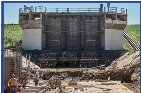
Uszadékterelő műtárgy építése
