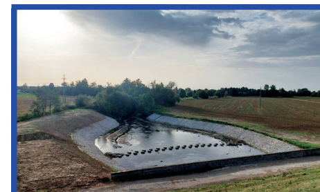
Lukácsházi árvízcsúcscsökkentő tározó - Alvízi csillapító medence rekonstrukció után
