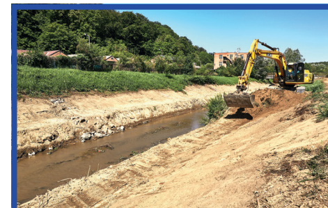
Gyöngyös-patak, mederrendezés
